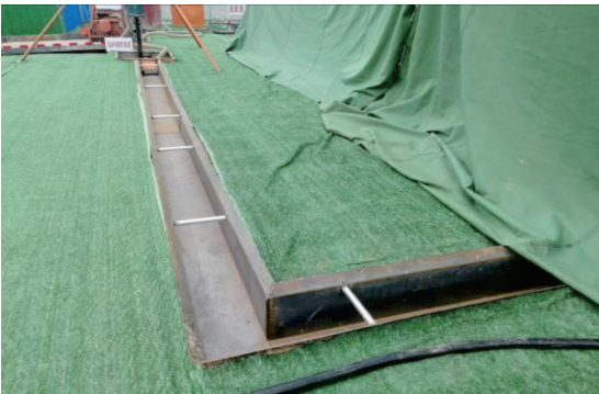
图 5 钢板制循环槽
